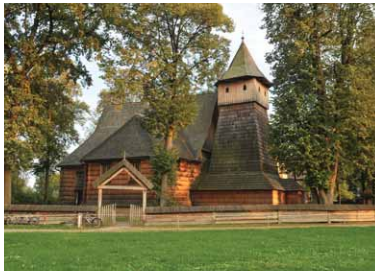
Binarowa, kościół św. Michała Archanioła
