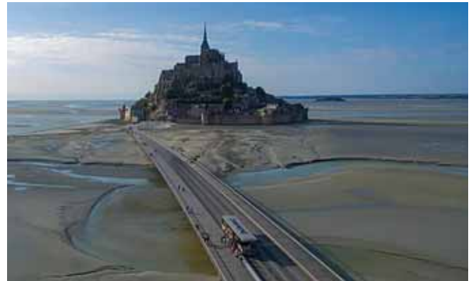
Wyspa Mont-Saint-Michel w czasie odpływu. Widoczny nowy most łączący wyspę ze stałym lądem, źródło: https://en.wikipedia.org/wiki/Mont-Saint-Michel#/media/File:Mont-Saint-Michel_Drone.jpg
