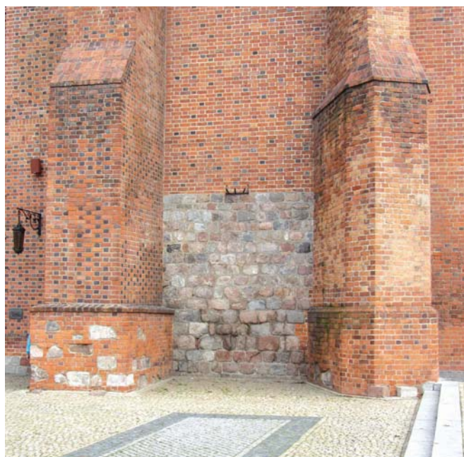
Rys. 1. Fragment kamiennego, romańskiego muru, zbudowanego głównie ze skał magmowych przyniesionych przez ładłod z Skandynawii, można wykorzystać do przekazania informacji o typach skał oraz o zlodowaceniach plejstoceńskich
