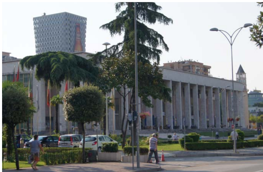
Pałac Kultury z siedzibą Opery
