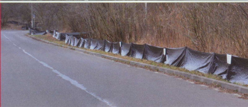
Ogrodzenie zabezpieczające przed wchodzeniem płazów na drogę
