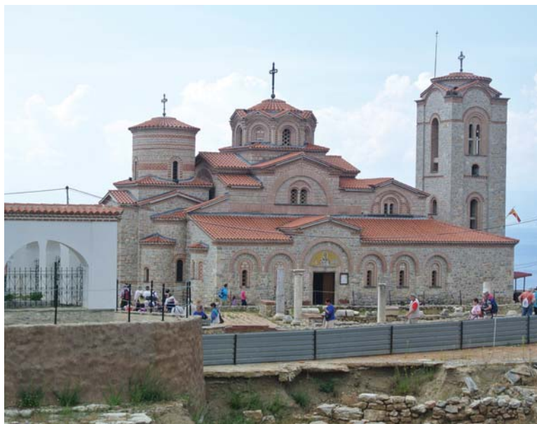
Cerkiew św. św. Klimenta i Pantalejmona po niedawnej renowacji
